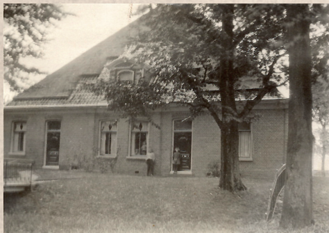
De Laanhoeve is vernoemd naar de Laanweg, zoals deze tot 1906 heette. De twee voordeuren waren een teken van rijkdom. Diverse boerderijen zijn voorzien van twee voordeuren.
